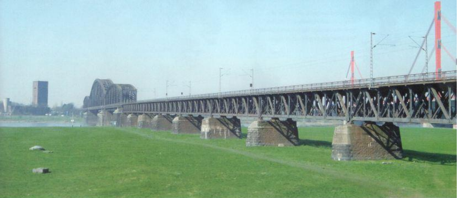
Ein altes Wahrzeichen für die Rheinschifffahrt: die Haus-Knipp-Eisenbahnbrücke neben der Beckerwerther Brücke bei Duisburg (im Hintergrund).
